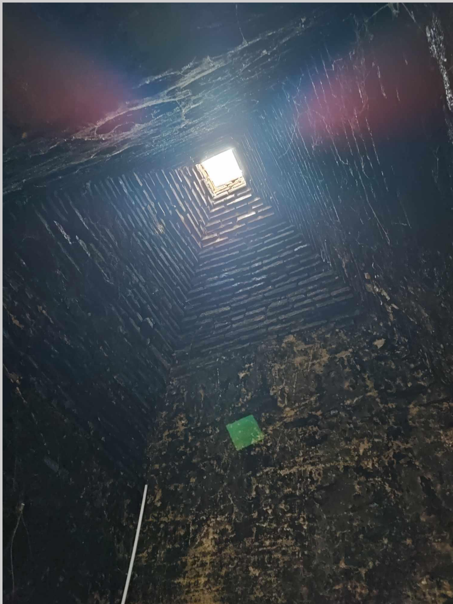
Velký komínový průduch, který odváděl kouř z místnosti pekárny nad střechu.
